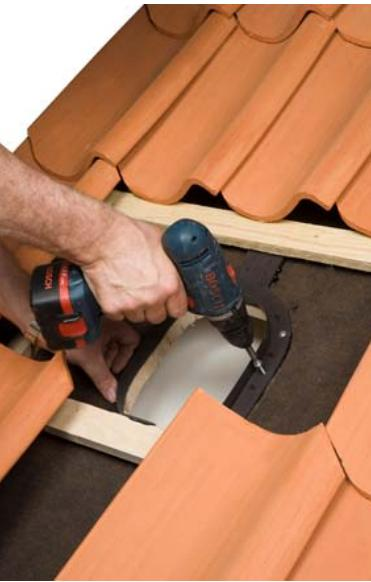
**RUS:** Прибить уплотнитель гидрозатвора гвоздями к сплошной обрешетке. При полимерной пленке и отсутствии сплошной обрешетки, завести уплотнитель под пленку, наколоть пленку на шипы и сильно прижать пленку к промазанному силиконом уплотнителю. Закрепить выступы уплотнителя шурупами к верхней и нижней планке обрешетки.
