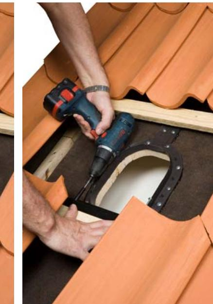
**RUS:** Планку упора закрепить к нижней рейке обрешетки двумя шурупами 80 мм строго симметрично относительно отверстия.
