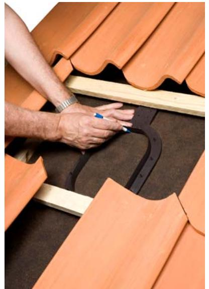
**RUS:** Очертить отверстие в подкладочном материале по внутреннему контуру уплотнителя гидрозатвора, прижав его к нижней рейке обрешетки.
