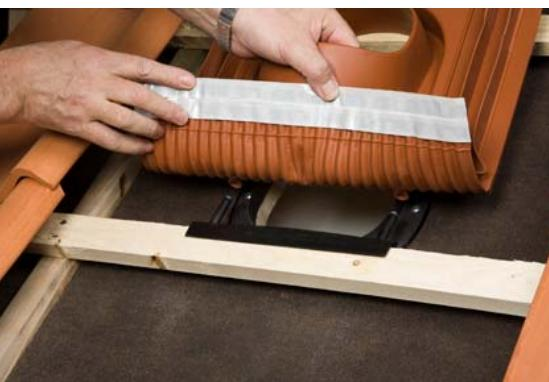
**RUS:** Снять черепички ниже отверстия. Вставить штыри упора в отверстия проходного элемента. Если обрешетка очень частая, то в некоторых случаях приходится подстрогать рейки для размещения выступа на нижней части проходного элемента между рейками.
